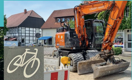
Bau der Velo-Route und Umbau Innenstadt (ISEK)
