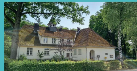
Renovierung Gemeindehaus Kölkebeck
